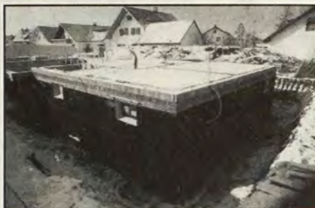
Platon P6 szellőztető-, szivárgó szigetelést védő rendszer
